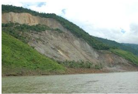
图 2 小湾水电站库区“7.20”滑坡体
