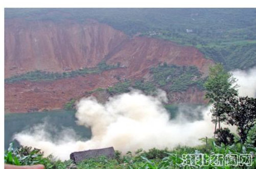
图 4 水布垭库区大堰塘“6.15”滑坡体
