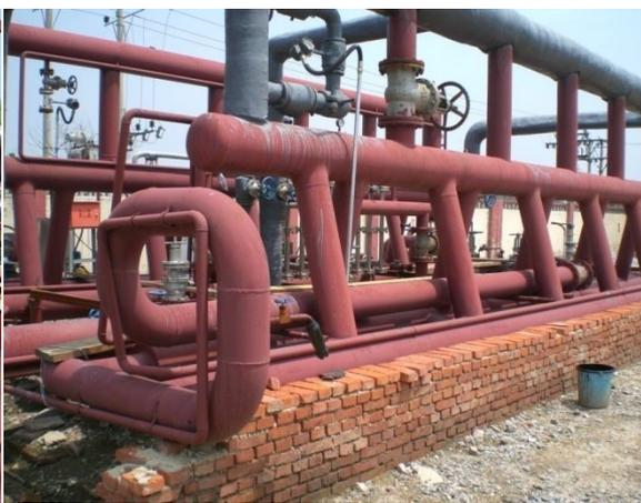
图 2 T 型管多分岔管路
