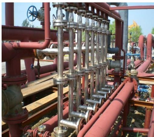
图 1 柱型旋流器组
